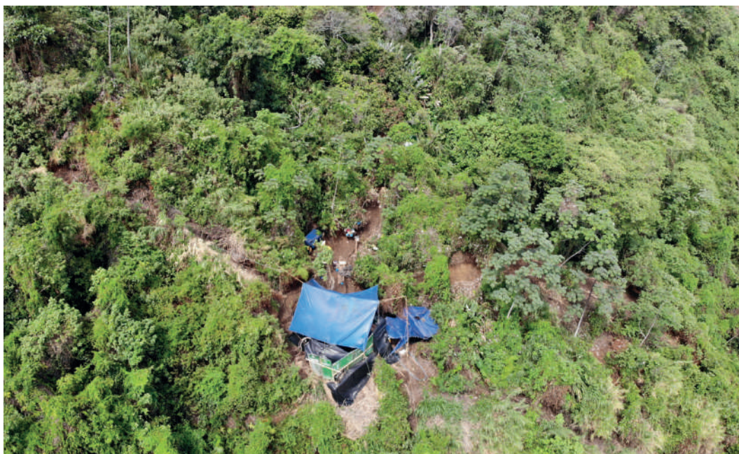
Fotografía 5: Plataforma de exploración de la empresa Minerales Santa ANA S.A.S.
