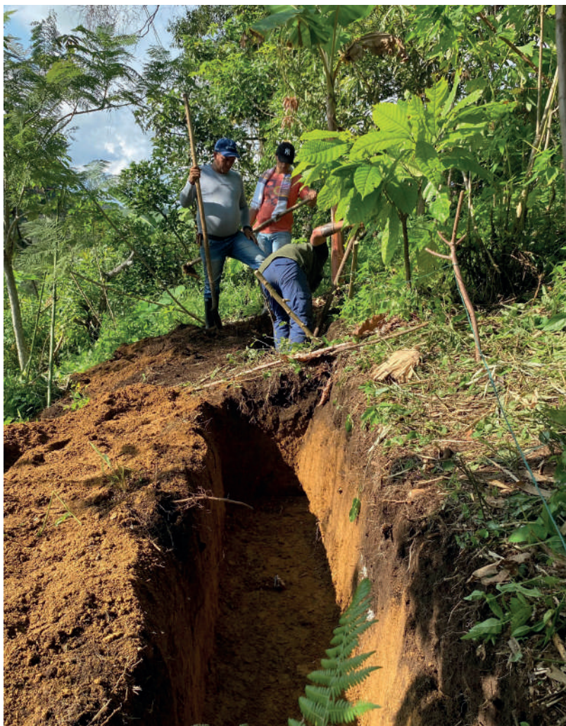
Fotografía 9: Zanjas de infiltración, Vereda La cabaña, Mariquita
