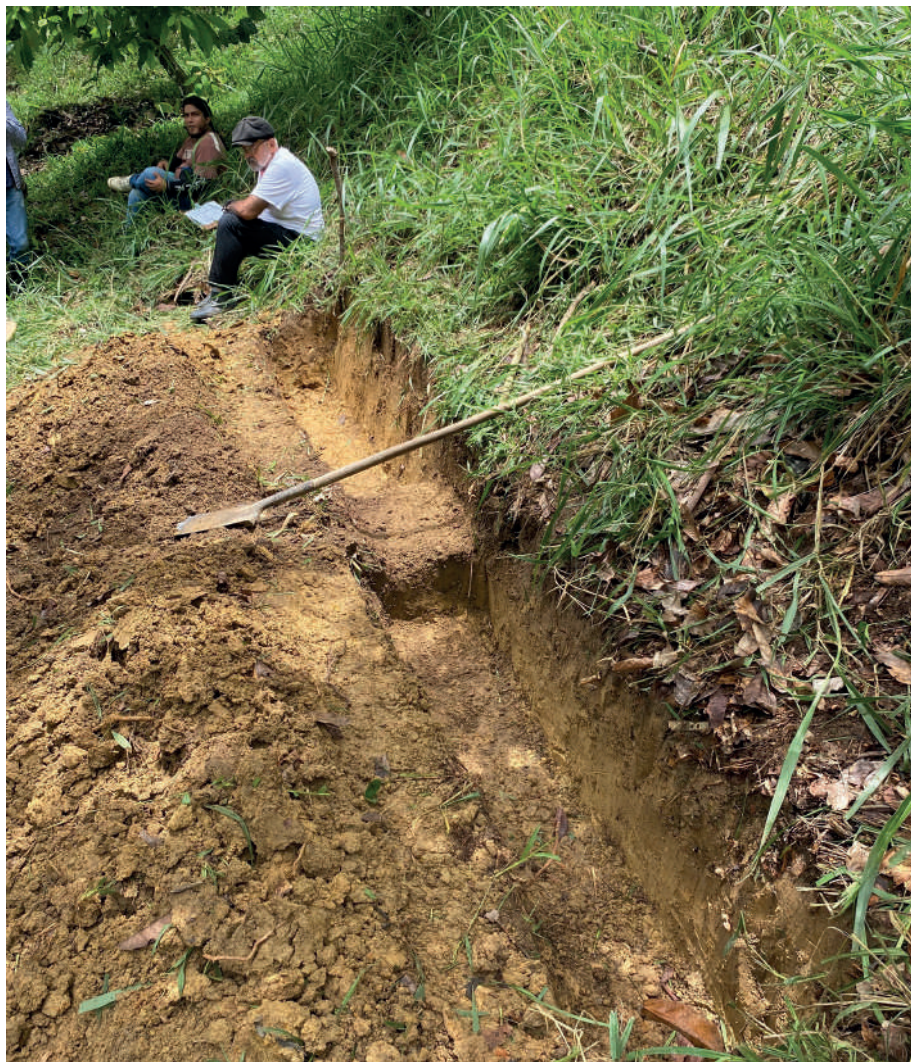
Fotografía 9: Zanjas de infiltración
